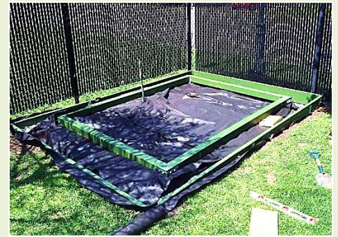
3. 铺底：底面铺上厚塑料膜可以有效防止碎石流失
