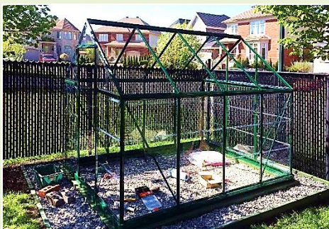
6. 房顶：房顶是除了地基外最难安装部分。严格按照说明书是成功的保证
