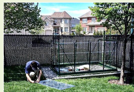
安装房顶进行中
